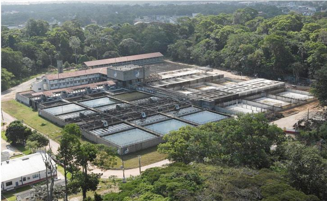
Figura 2.4 - Estação de Tratamento de Água Bolonha Fonte: http://ananindeuamais.com.br
